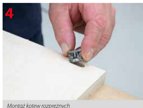
Montaż kotwy rozprężnej
