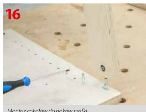
Montaż cokołów do boków szafki
