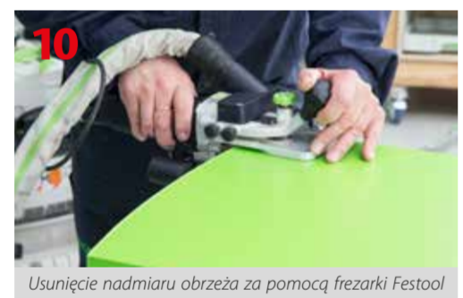
Usunięcie nadmiaru obrzeża za pomocą frezarki Festool OFK 700
