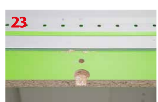
Wykonane otwory w tylnej ścianie szafki i narzędzia Festool służące do ich wykonania
