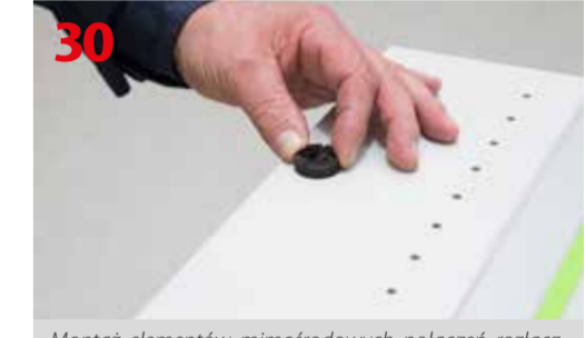
Montaż elementów mimośrodowych połączeń rozłącznych
