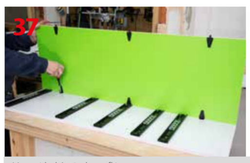
Montaż boków i tyłu szafki
