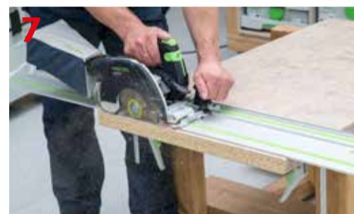
Cięcie blatu kuchennego za pomocą pilarki Festool HKC 55 EB
