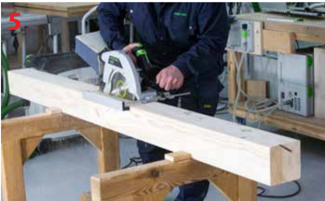
Rozcinanie grubego elementu z użyciem prowadnicy równoległej
