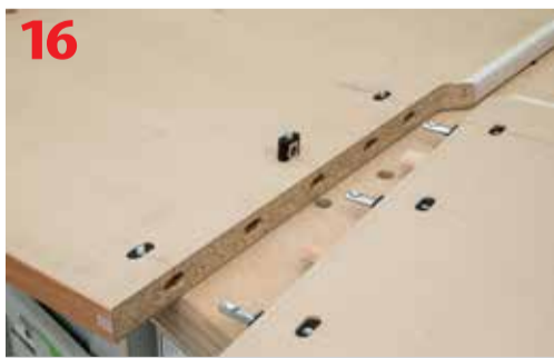
Prawidłowy montaż łączników Domino
