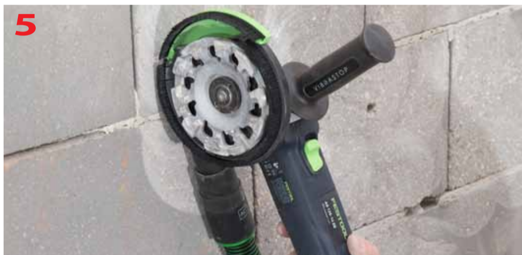
Szlifowanie wyrównujące bloczków betonowych ze ściernicą diamentową (tarczą do ściernia)
