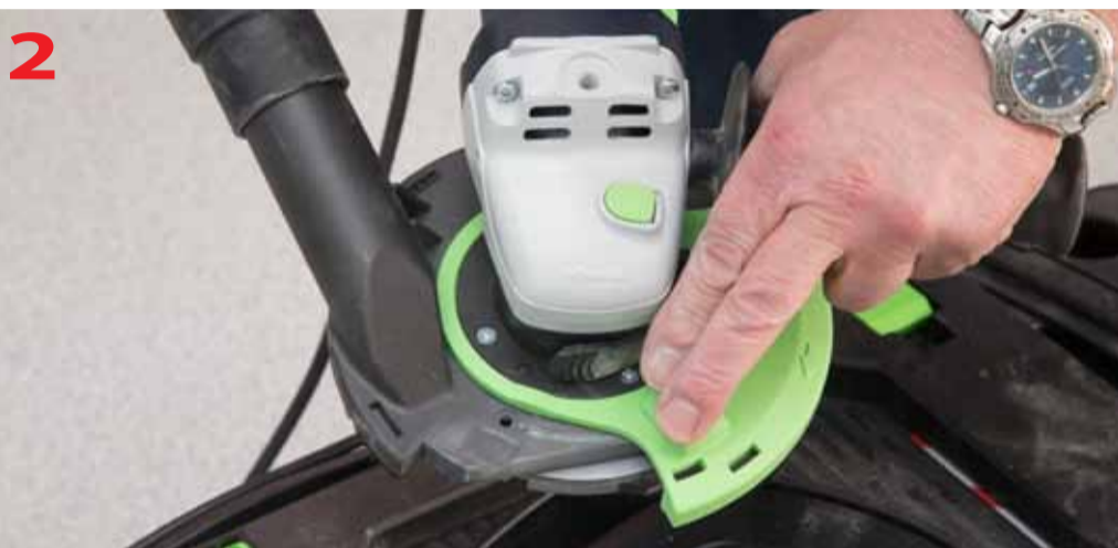
Odchylenie osłony w celu dojścia do ściany
