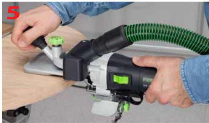
Frezowanie usuwające nadmiar obrzeża
