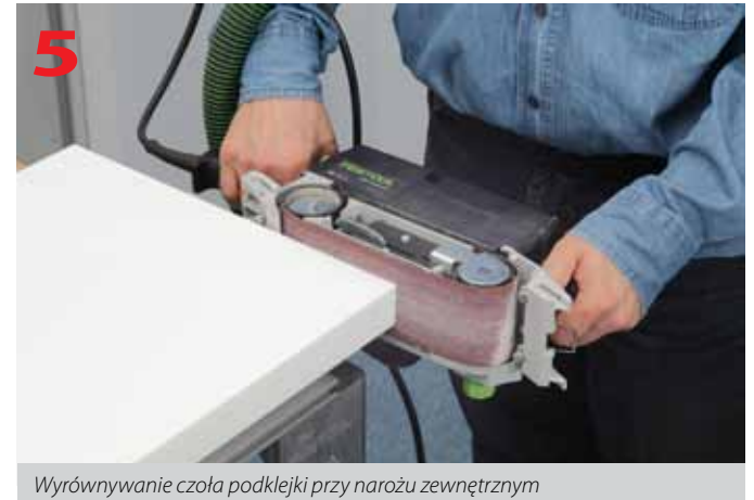
Wyrównywanie czoła podklejki przy narożu zewnętrznym
