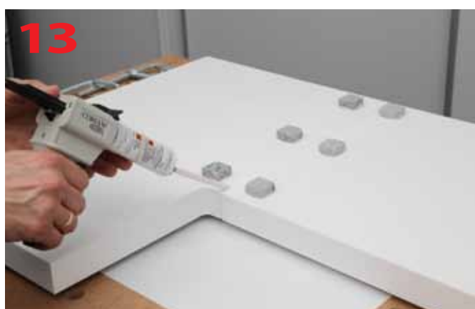
Nakładanie kleju w przestrzeń pomiędzy elementami blatu
