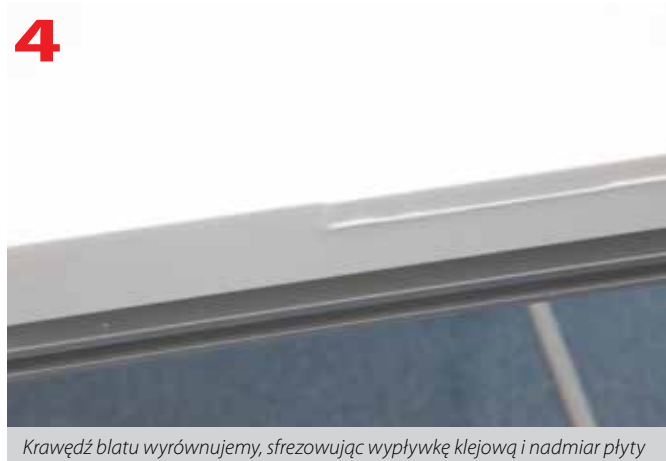
Krawędź blatu wyrównujemy, sfrezowując wypyłkę klejową i nadmiar płyty
