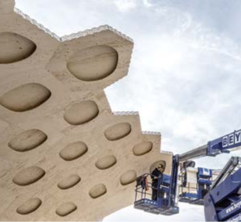
→ Puste w środku kasetony zostały wstępnie częściowo zmontowane i połączone ze sobą na miejscu budowy bez użycia dźwigarów i wsporników.
