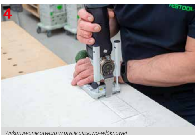
Wykonywanie otworu w płycie gipsowo-włóknowej
