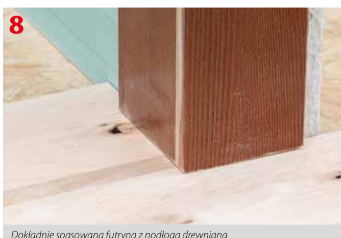
Dokładnie spasowana futryna z podłogą drewnianą
