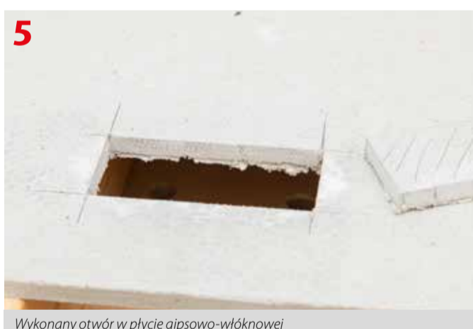
Wykonany otwór w płycie gipsowo-włóknowej
