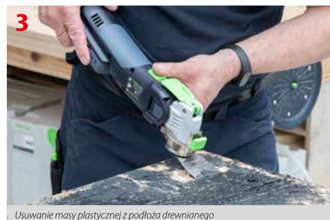
Usuwanie masy plastycznej z podłoża drewnianego
