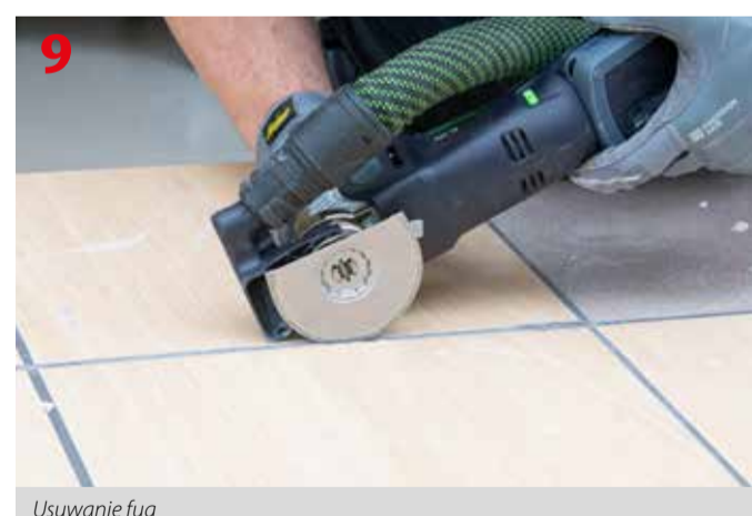
Usuwanie fug
