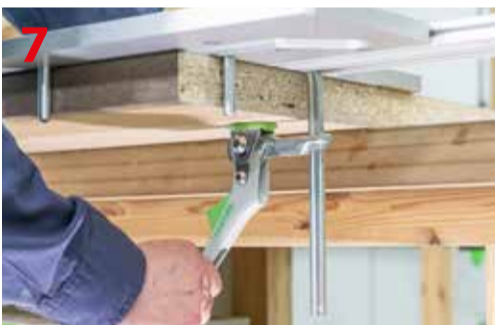
Montaż drugiego ścisła w profilu szablonu APS 900/2
