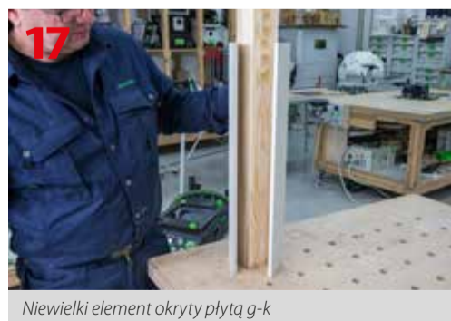
Pokrywanie elementu drewnianego płytą g-k
