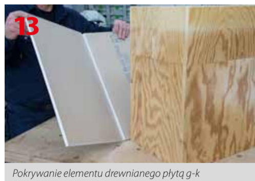
Wykonany wpust „V” w płycie g-k
