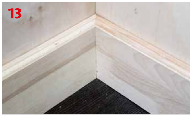
Dokładnie spasowane cokoły narożne
