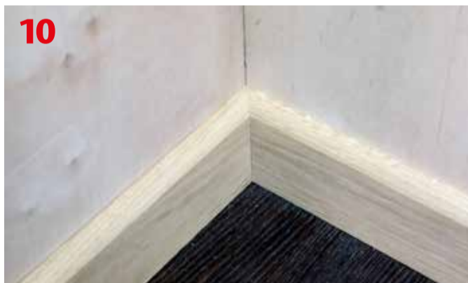
Dokładnie spasowane przyściennne listwy narożne
