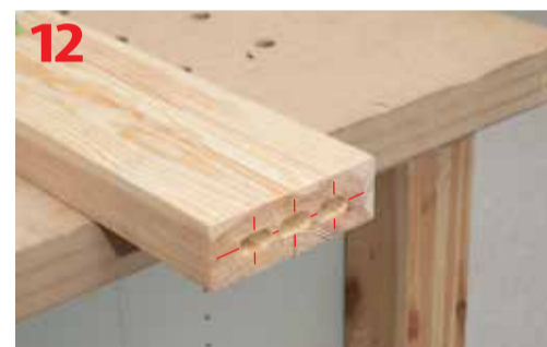
Wyfrezowane czoło elementu oskrzyni
