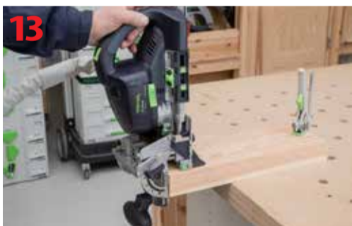
Frezowanie boku elementu oskrzyni
