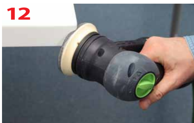
Szlifowanie wykańczające zaokrąglonego naroża zewnętrznego
