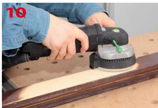
Szybkie usuwanie farby podczas renowacji ramy okiennej
